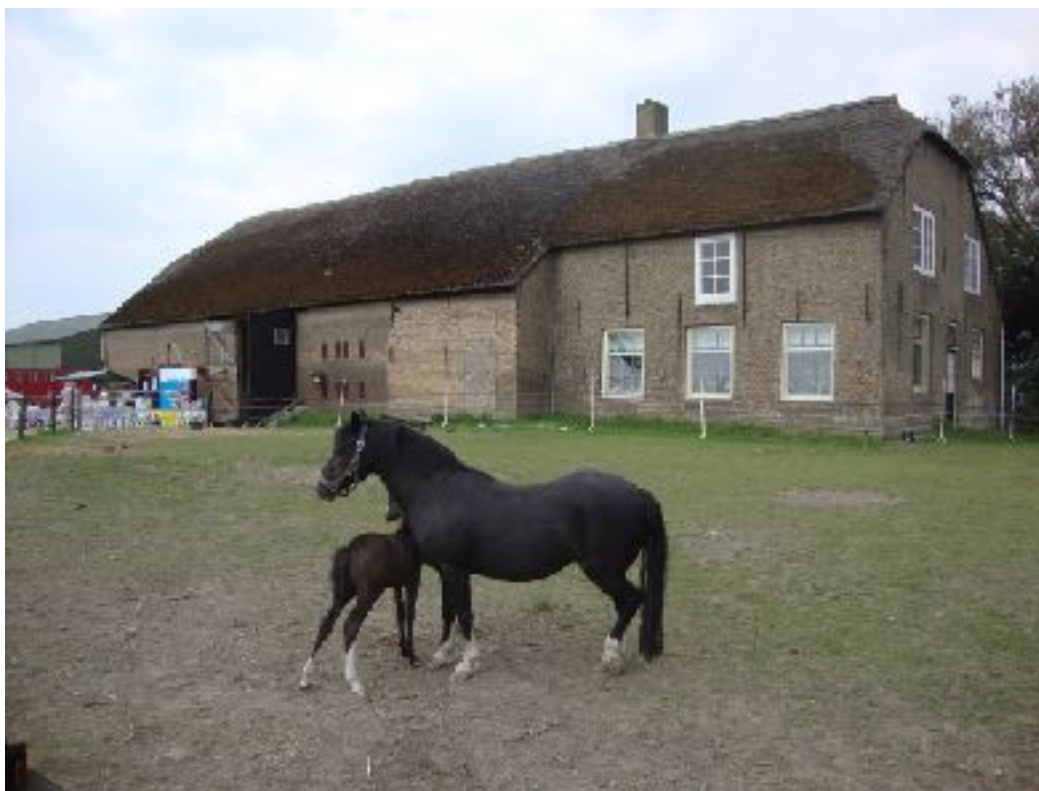
Hoeve Noordburg met de voorgevel naar de Koedood gericht
